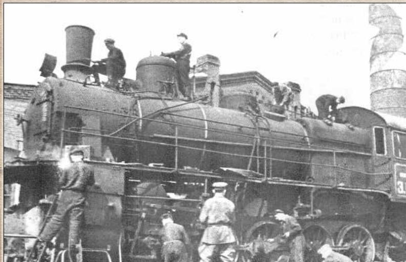
*Техническое обслуживание паровоза, проводимое паровозной бригадой.*
